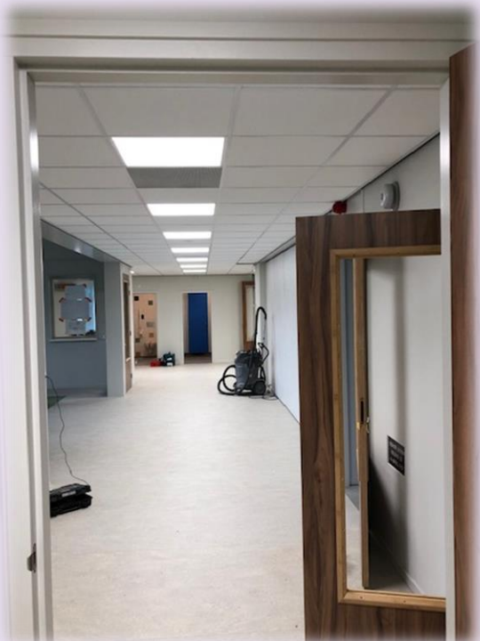
Gang/openleerruimte, vanaf onderbouw gefotografeerd
